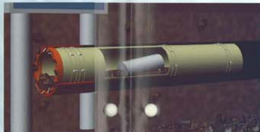
■ コンクリート杭切断状況
