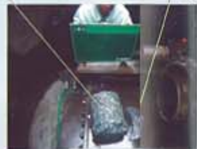
コンクリート 鋼製ケーシング
