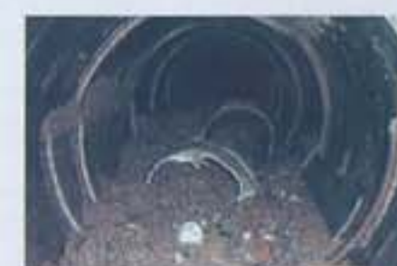
既設管・掘削土排土
