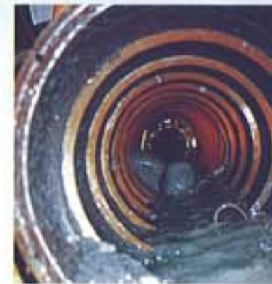
■ 排土状況 (ケーシングロッド内)
