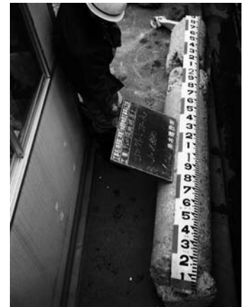
写真-7 コンクリート切断状況
