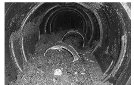
写真-9 既設管取込状況
