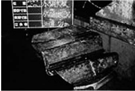
写真-4 鋼矢板切断状況
