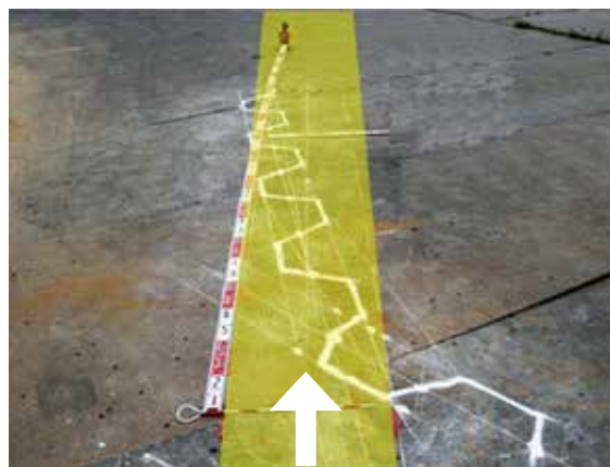
写真-2 残置鋼矢板と推進鋼管との位置関係
