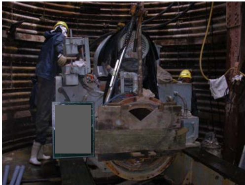
写真-5 本管布設工程（ダクタイトイル管挿入）
