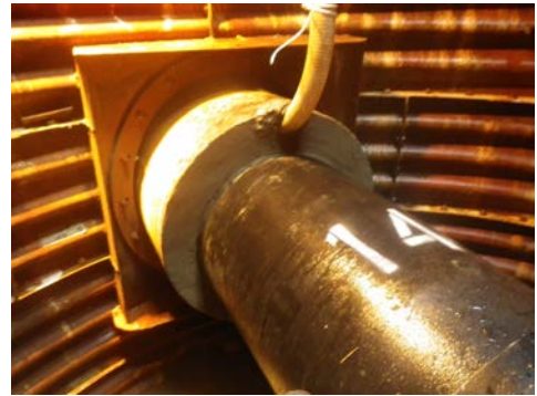
写真-4 本管布設工程（ダクタイトイル管挿入完了）
