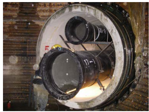
写真-6 本管布設工程（SH800型を使用）
