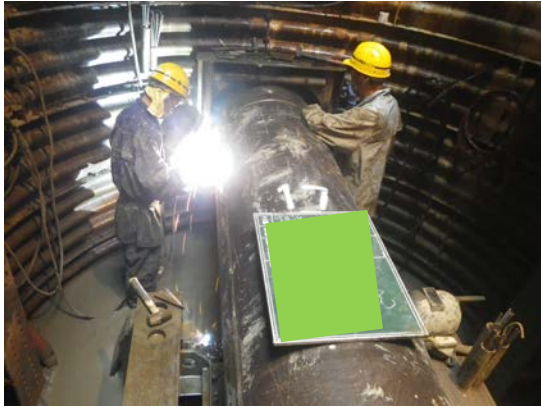
写真-1 推進工程（鋼管推進）
