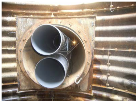
写真-7 本管布設工程(塩ビ管挿入)
