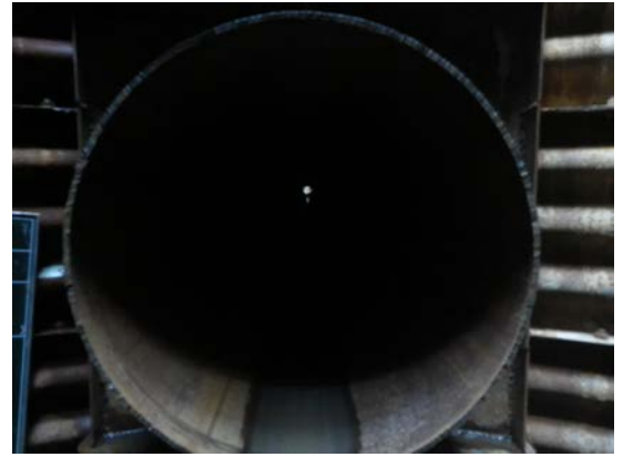
写真-2 推進工程（鋼管推進完了）
