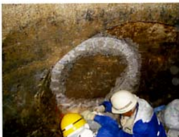
写真-5 M・P壁切削後到達したメタルビットタイプ刃先
