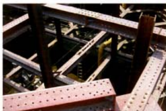
写真-3 SP棟掘削中立坑 (今回の発進側)
