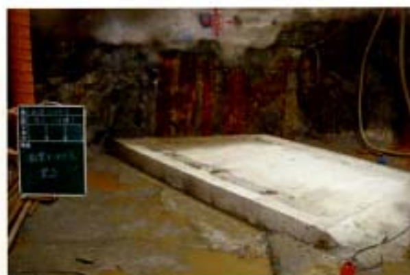
写真-4 基礎ベースコンクリート打設完了写真
